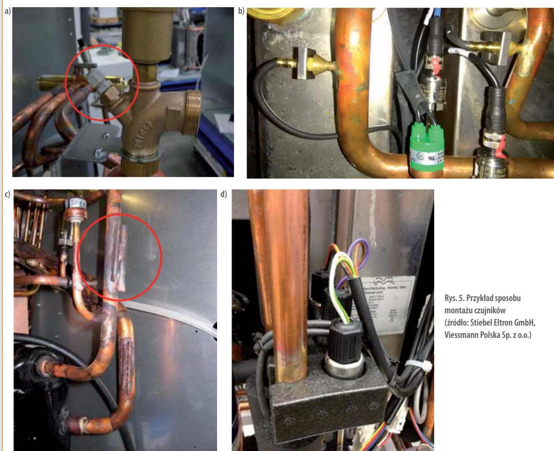
Rys. 4. Przykład montażu czujnika powietrza zasysanego oraz przetworników ciśnienia niskiego – ND i wysokiego –HD (źródło: Stiebel Eltron GmbH)
