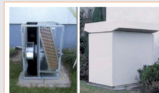
Rys. 4. Przykład montażu pompy ciepła A/W typu monoblok (źródło: Stiebel Eltron Polska Sp. z o.o.)
