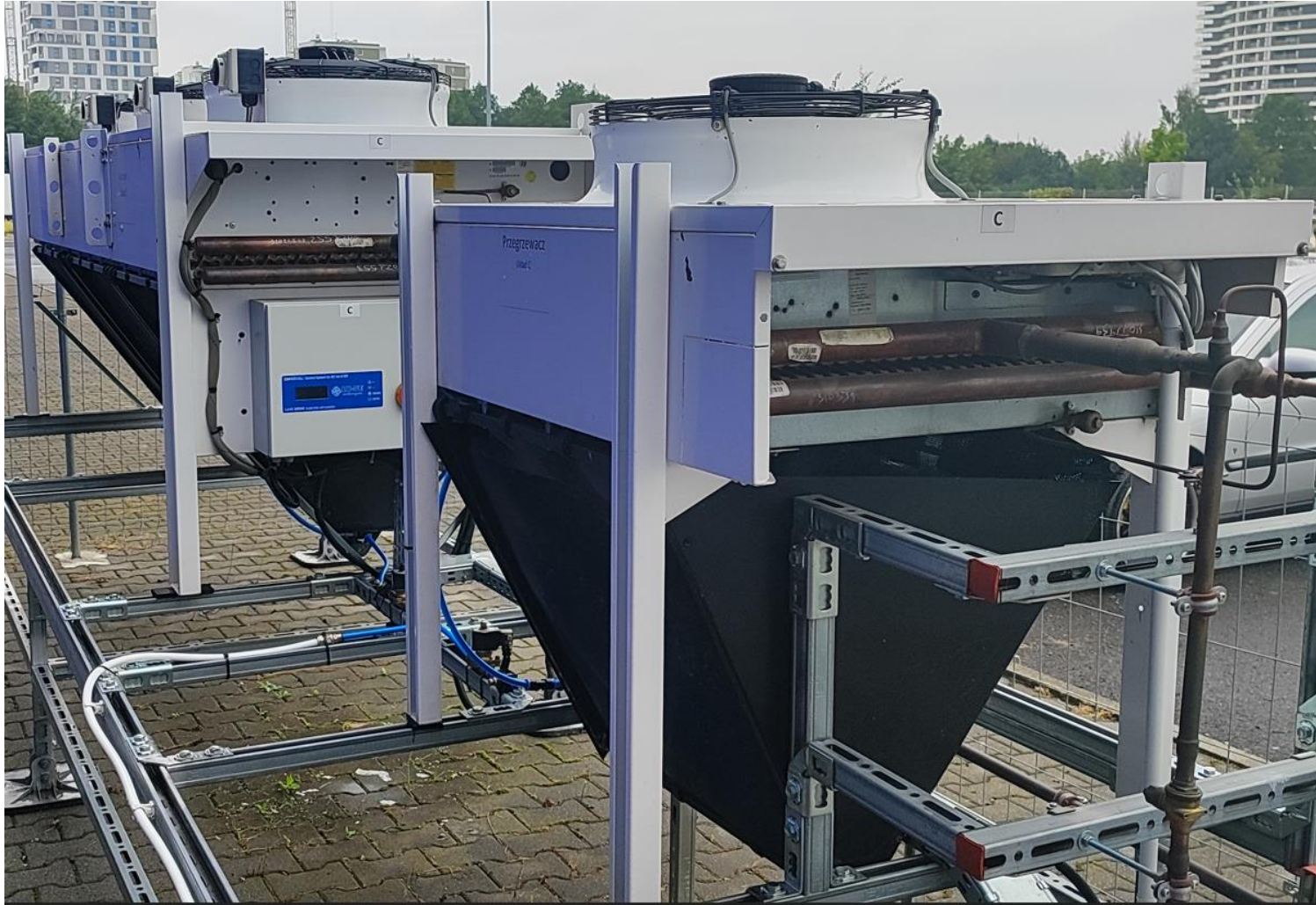
Widok dwóch gascoolerów (chłodnic gazu) LU-VE ze zwilżanymi tkaninami
