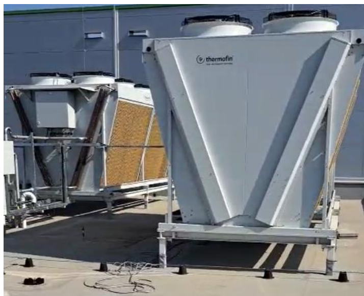
Widok chłodnicy gazu z padami Thermofin
