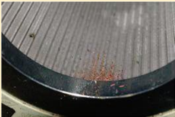
Wióry miedziane na filtrze ssawnym
