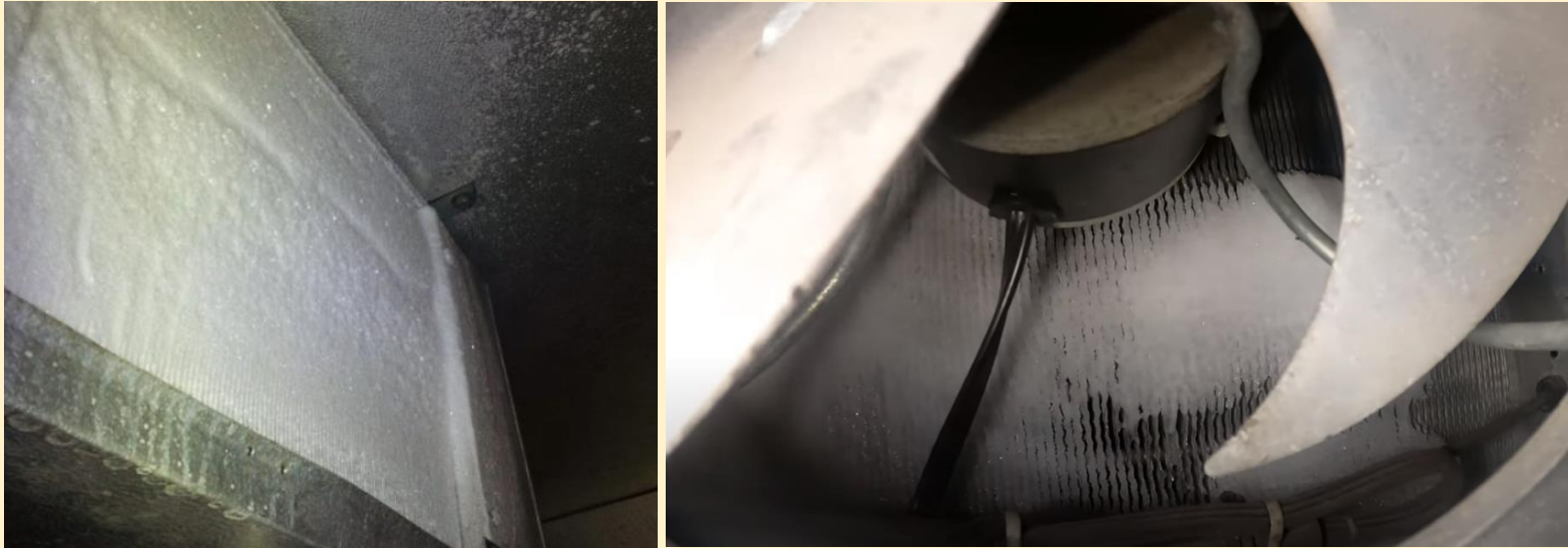
Chłodnica powietrza całkowicie zasroniona i częściowo obrosnięta lodem
